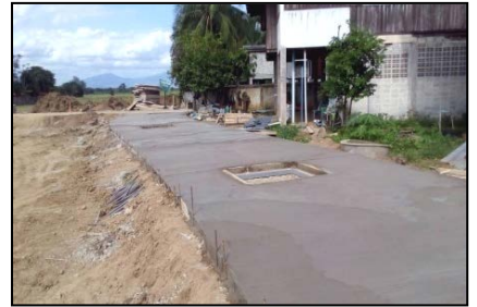
โครงการวางท่อระบายน้ำคอนกรีตเสริมเหล็ก ชนิดมีบ่อพักพร้อมถนนคอนกรีตเสริมเหล็กบริเวณลำเหมืองพ่อเลี้ยง ข้างบ้านนายถัย สายทอง หมู่ที่ ๖
