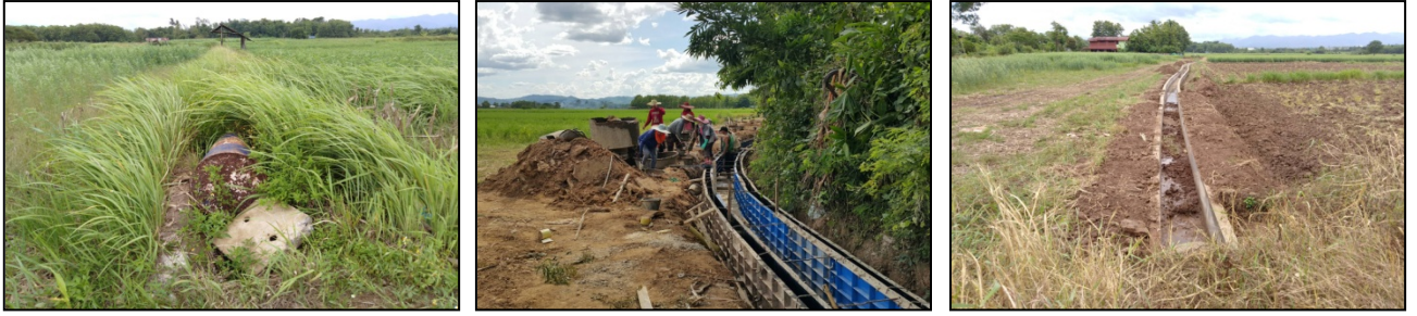
โครงการวางท่อระบายน้ำคอนกรีตเสริมเหล็กชนิดมีป้อพักพร้อมขยายฝิวจากรองกรตเสริมเหล็ก บริเวณหน้าบ้าน นายสม ชัดมะละ ถึงร้านค้าสหกรณ์หมู่บ้าน หมู่ที่ ๒
