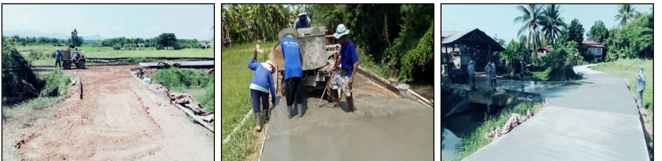
โครงการก่อสร้างถนนคอนกรีตเสริมเหล็ก (ช่วงที่ ๑) บริเวณถนนเขตติดต่อหมู่ที่ ๓ ถึงบ้านนายนิคม ปัญญา หมู่ที่ ๔
