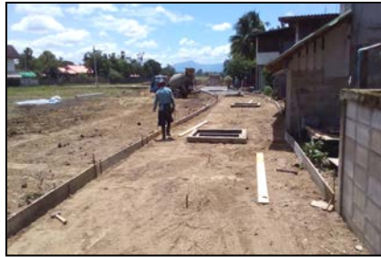
โครงการวางท่อระบายน้ำคอนกรีตเสริมเหล็ก ชนิดมีบ่อพักพร้อมถนนคอนกรีตเสริมเหล็กบริเวณลำเหมืองพ่อเลี้ยง ข้างบ้านนายถัย สายทอง หมู่ที่ ๖
