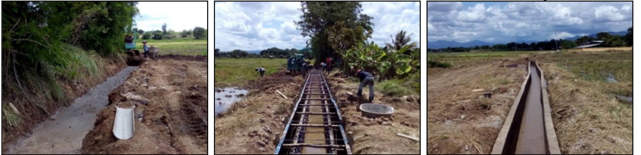
โครงการก่อสร้างรางส่งน้ำคอนกรีตเสริมเหล็ก บริเวณที่นายนายพล อินทรีย์ ถึงลำเหมืองร่องเสี้ยว หมู่ที่ ๓
