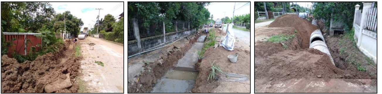
โครงการวางท่อระบายน้ำคอนกรีตเสริมเหล็กชนิดมีป้อพักพร้อมขยายฝิวจากรองกรตเสริมเหล็ก บริเวณหน้าบ้าน นายสม ชัดมะละ ถึงร้านค้าสหกรณ์หมู่บ้าน หมู่ที่ ๒
